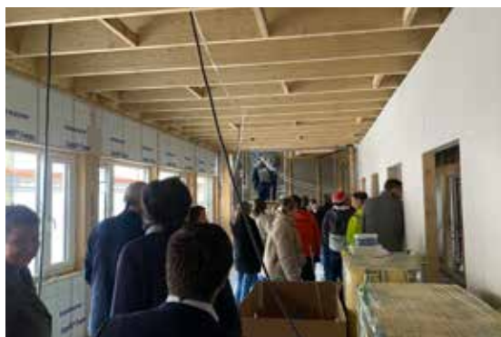
NYTT BYGG: I slutten av oktober fikk de ansatte ta en titt på de uferdige kontorlokalene i Askim.
