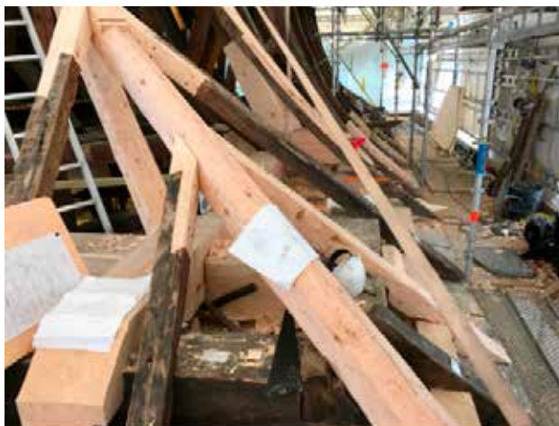
Under tårntaket er råttent treverk byttet ut med friskt treverk. Der det er mulig å bevare deler av en stokk, gjør vi det, og feller inn nye deler som erstatning for det som fjernes.
