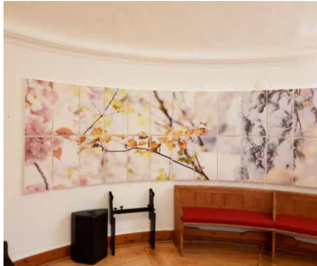
Nye akustikkplater gjør at en kan høre hva som blir sagt i sakristiet. Foto: Akasia
