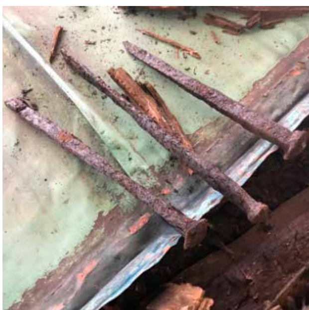
De lengste «spikrene» i tårnet er ca. 50 cm.
