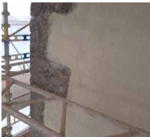
All sementpuss er fjernet og erstattet med kalkpuss. En del ødelagte steiner oppover i tårnet er fjernet. Nye steiner er hugget til og satt inn. Alle murankre er rehabilitert – noen er skiftet ut med nye.
