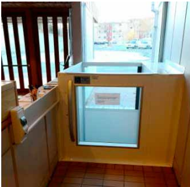
Ny løfteplattform i Fyllingsdalen kirke, øvre del.
