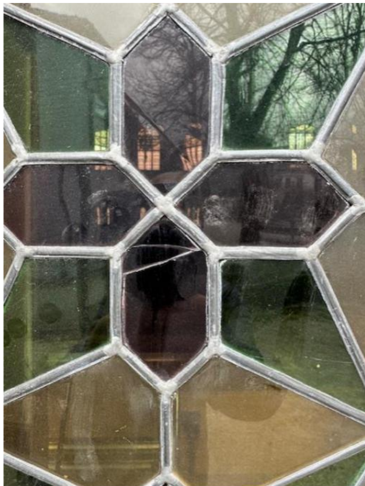
Vindu nr. Ø 201 Store utbøyinger der glasset sprekker og er på vei ut av blyprofilen p.g.a. u
