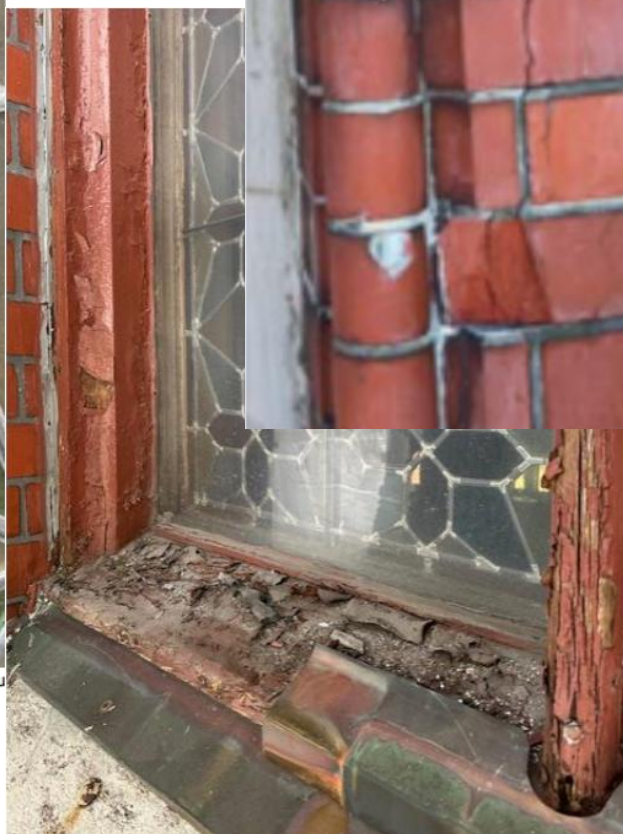
Vindu nr. Ø 201 Store utbøyinger der glasset sprekker og er på vei ut av blyprofilen p.g.a. u
