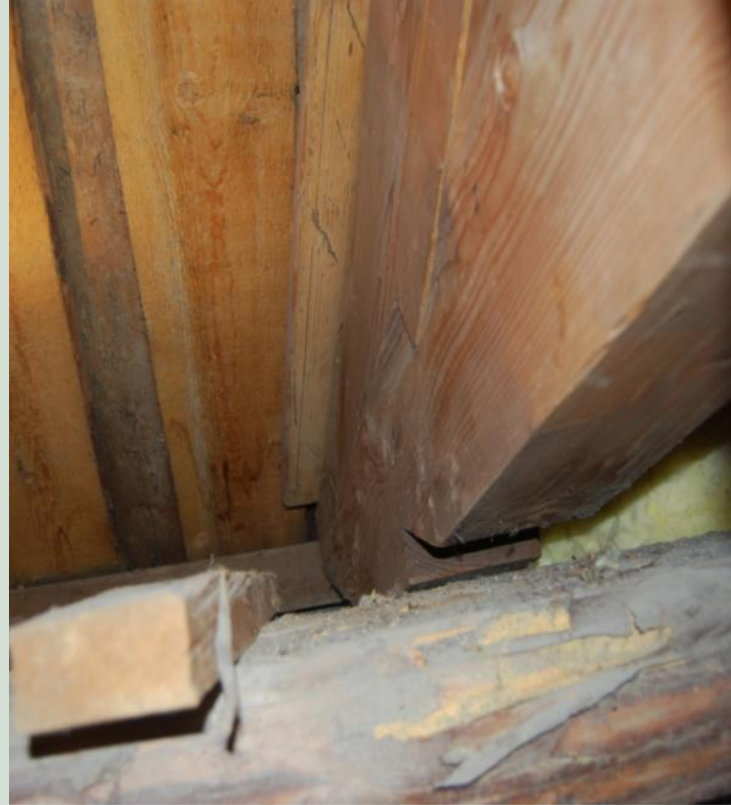
Utglidninger i 2 knutepunkt i sperrebind 2
