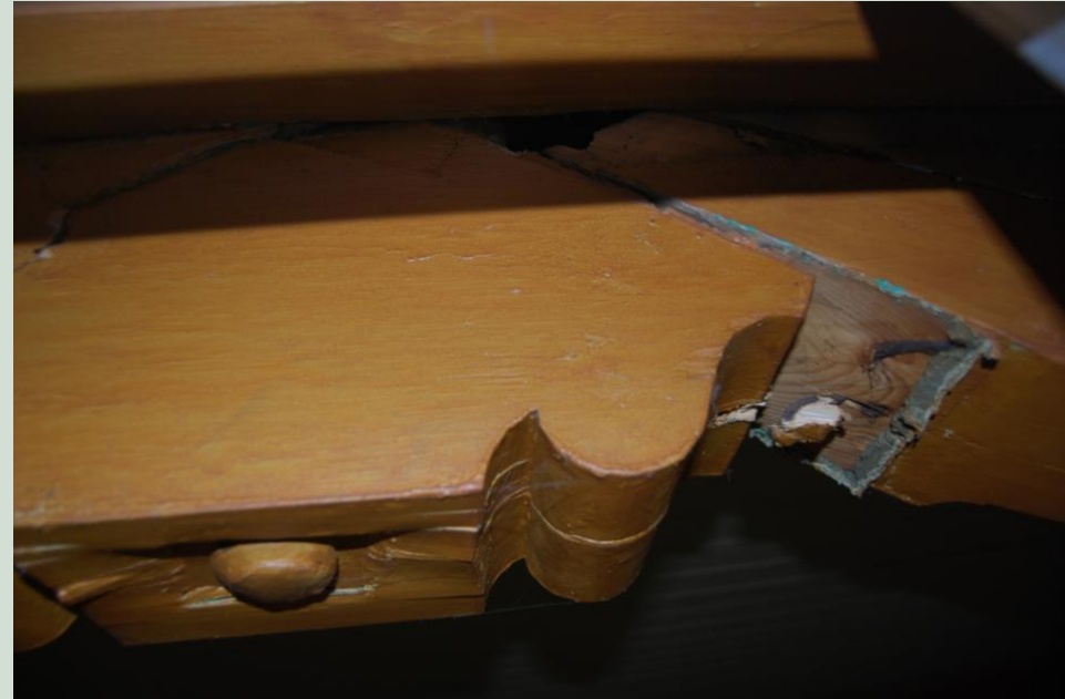
Utglidninger i 2 knutepunkt i sperrebind 2
