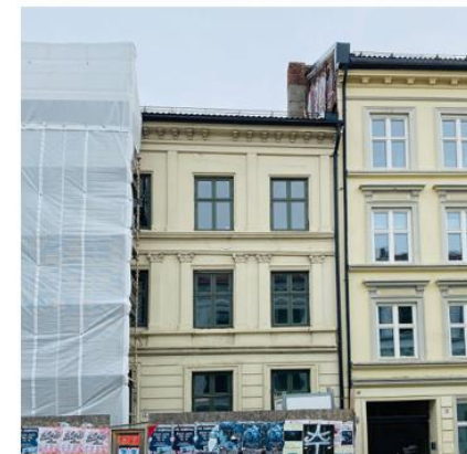
Ved rehabilitering eller oppgradering må man først gjøre seg kjent med bygningens oppbygning, vemestatus og hvilke regelverk som gjelder. Foto: SINTEF
