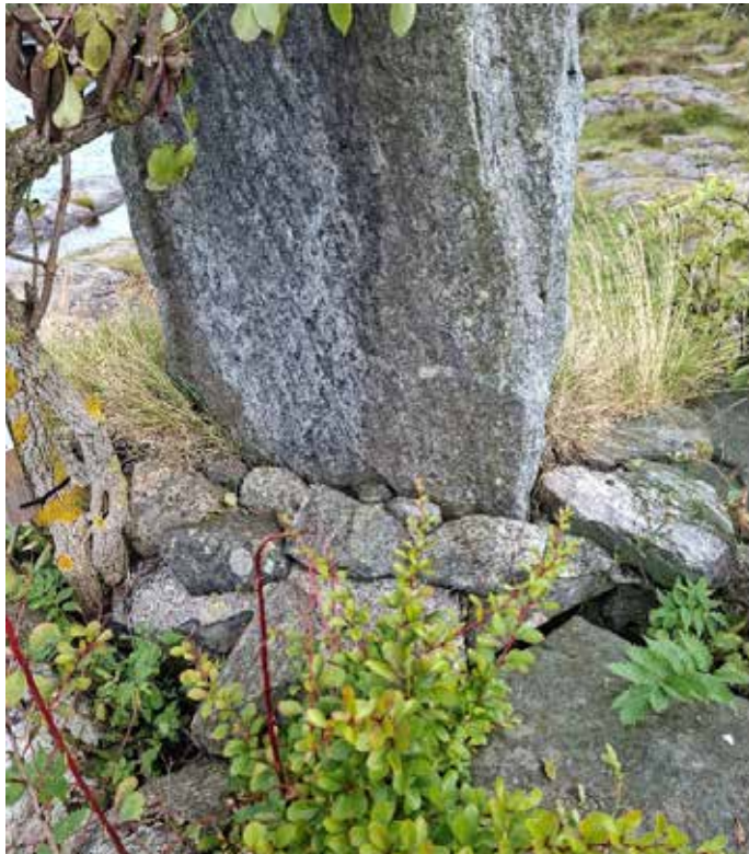
Støtten er støpt nederst og kilt med steiner der den kommer opp av bakken.
