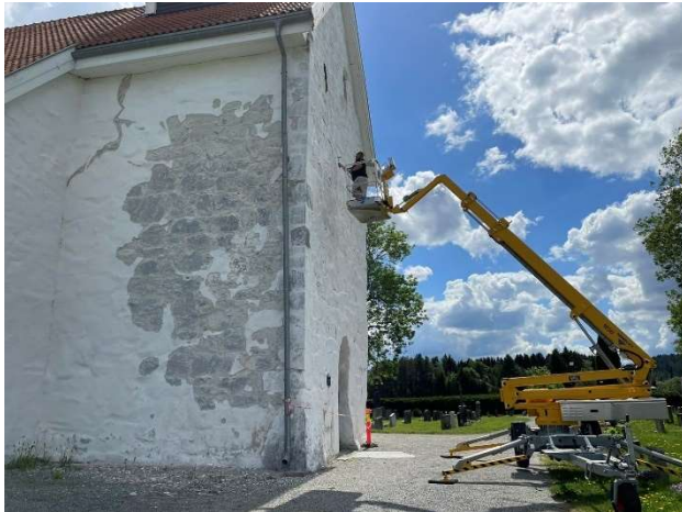
Fjerning av løs kalk etter frostskaide på tårnfoten til Enebakk kirke. Foto: Kirkekontoret.
