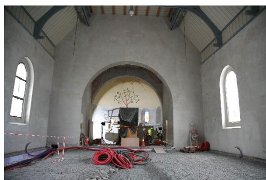
Ny oppbygging av kirkegulvet
