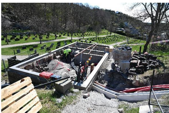
April 2020: Grøfter til energibrønner og varmelegg er lagt ned til uthuset, som skal bygges om til teknisk rom og lager.
