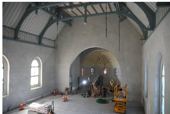
Foto 24.aug 2020. Rehab. av veggpuss pågår, Malerarbeider i tak pågår.
