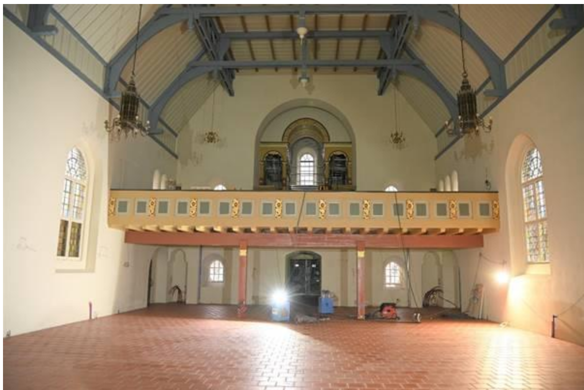
Kråkerøy kirke under rehab. 14. des. 2020 (foto HL)
