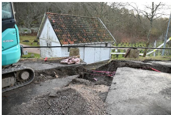
Det gamle uthuset før riving
