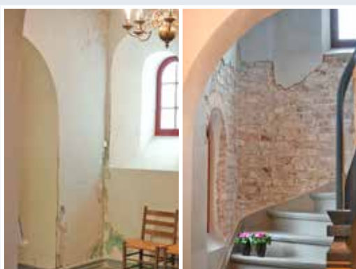
Rolvsøy kirke – utvalg av innvendige skader etter fukt i våpenhus, galleritrappes og kirkeskip.
