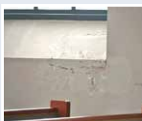
Rolvsøy kirke – utvalg av innvendige skader etter fukt i våpenhus, galleritrappes og kirkeskip.
