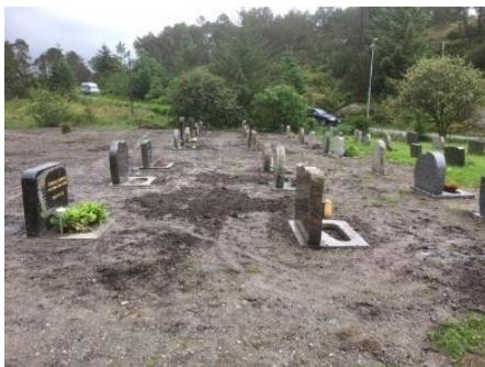
I tillegg til masseutskifting og heving av felt F, vart det gjort tiltak for å fjerne overflatevatn på dei øvste radene på felt B. Tilbakemeldingar tyder på at det fungerer, men at problemet med overflatevatn har flytta seg til radene nedanfor.
