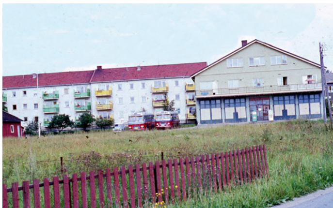
Solberggården, bussgarasjen i Åsenveien 12 på slutten av 1960-tallet, med blokkene i Torgveien 11 og 13 i bakgrunnen. Alt ble borte da Romakvartalet var klar for innflytting fra 2010.
