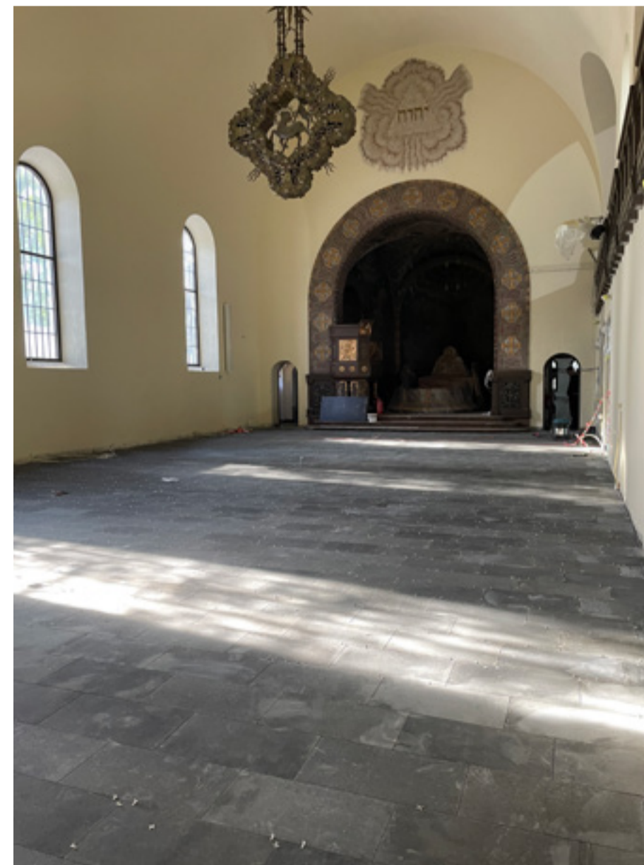
Ny skiferstein på alle gulv i førsteetasjen og underetasjen vil gi et godt og slitesterkt underlag. Under skiferen er det støpt inn vannbåren varme. Første etasje blir også nå terskelfri.
