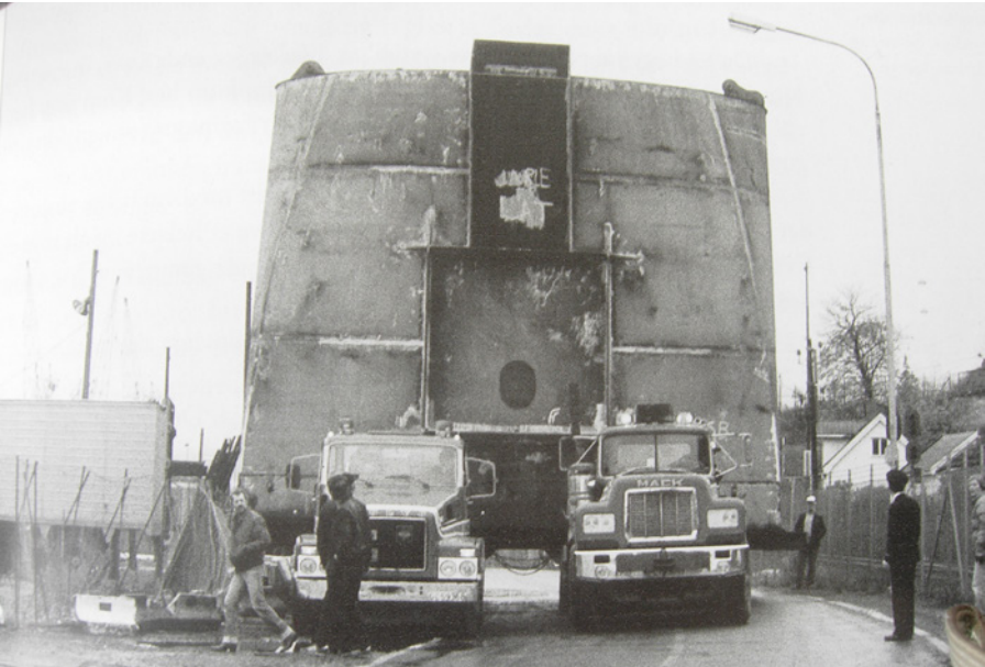
Transporten av fottene til Bingoplattformen ned til Sjørøya. Foto: Rolf Utgård.
