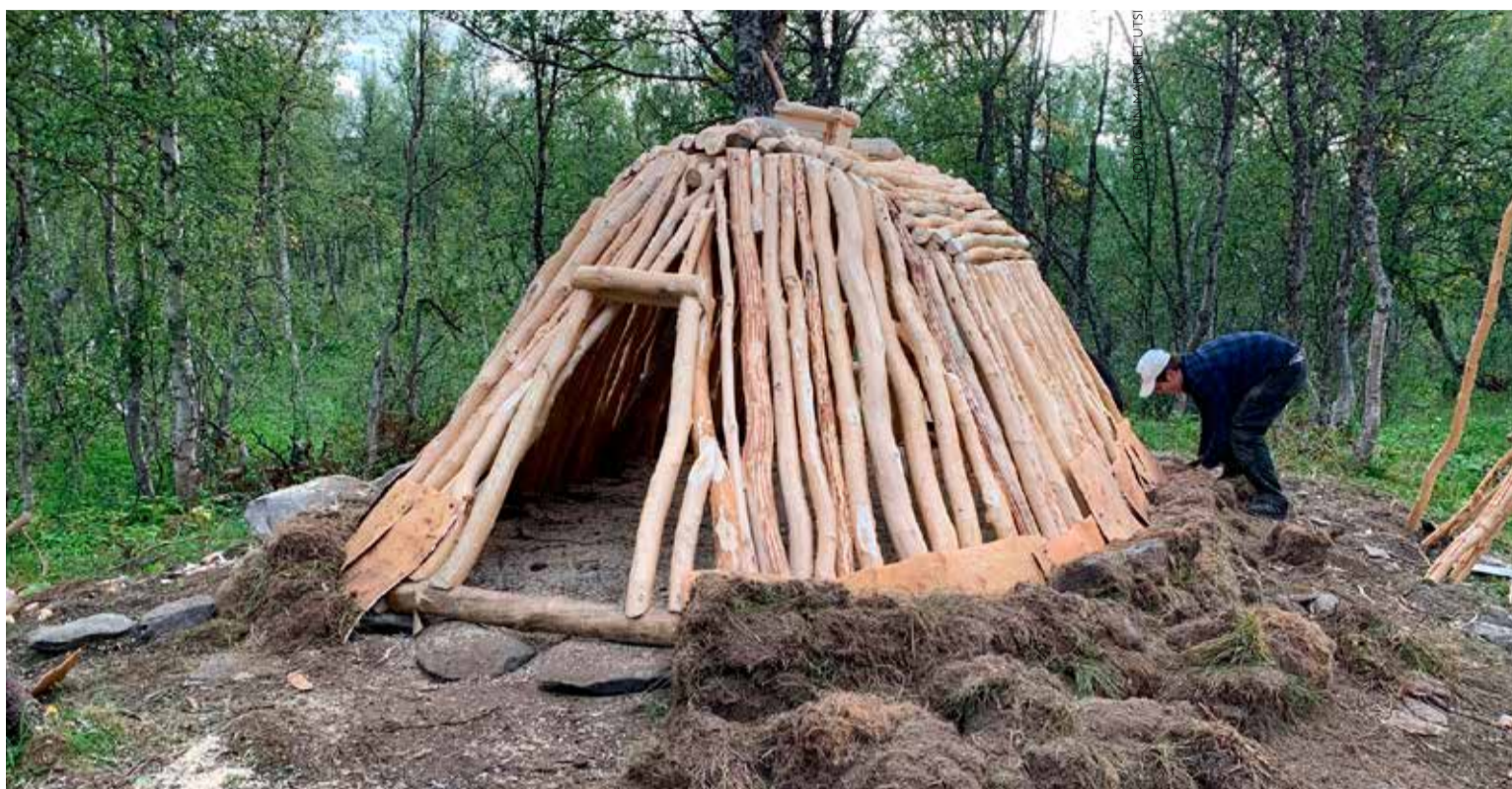
Geite-kåta i Atostugan ble satt opp i august. Her har reisverket kommet på plass og man har begynt å legge både bark og torv.
