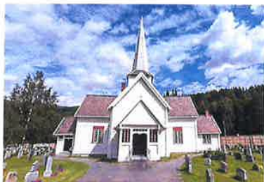
Vågå kirke er bygget av bindingsverk der det i veggene inngår deler fra en tidligere stavkirke i området. Klokkeklokkene er plassert i den lafete støpulen.
