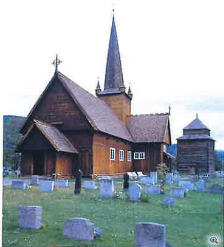
Vågå kirke er bygget av bindingsverk der det i veggene inngår deler fra en tidligere stavkirke i området. Klokkeklokkene er plassert i den lafete støpulen.
