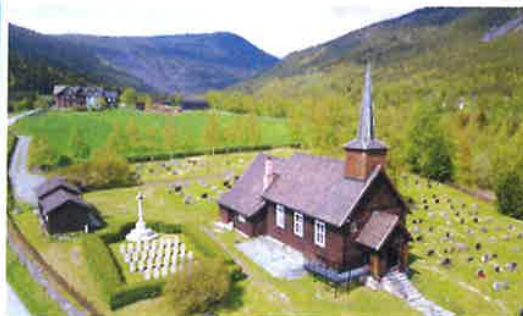
Vågå kirke er bygget av bindingsverk der det i veggene inngår deler fra en tidligere stavkirke i området. Klokkeklokkene er plassert i den lafete støpulen.
