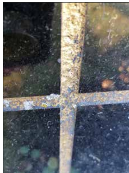
Innlegg med gull og lakk tapar seg og krev oppussing.
