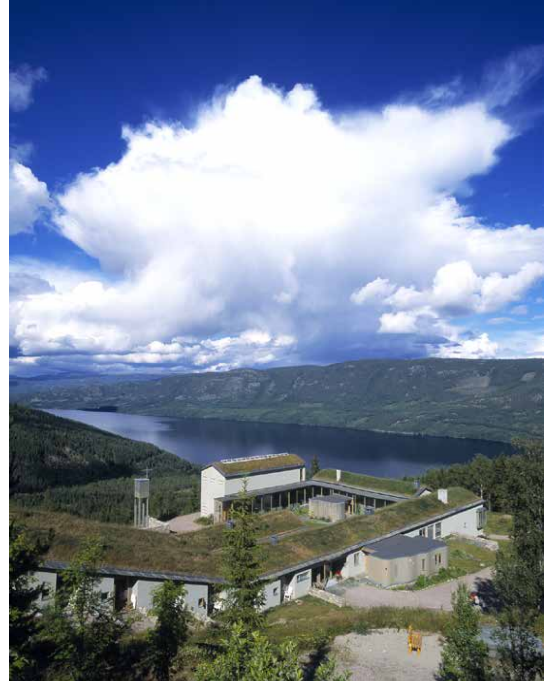
Lia Gård ligger praktfullt til - på bildet ser vi Nylia - hovedanlegget i retreat senteret. Nylia er tegnet av arkitekt Einar Dahle, Lia-venn fra Ris. Nylia ble bygget ved stor egen-og dugnadsinnsats på 80-tallet.
